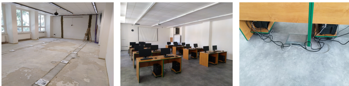
Rekonstrukce učebny NB08-IVT3
