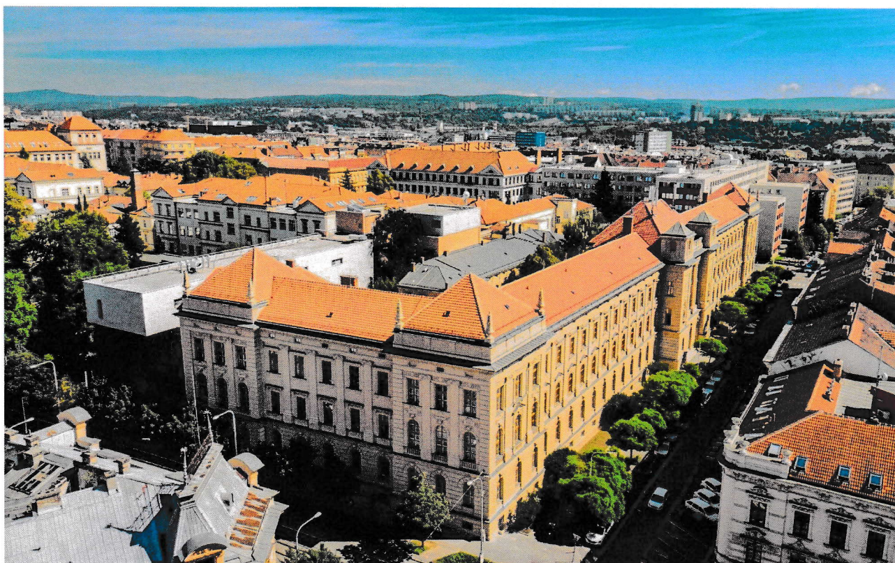
Budova školy na Sokolské ulici v Brně Zdroj: sokolska.cz
